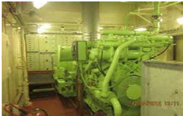
Γεννήτρια έκτακτης ανάγκης / Emergency diesel generator
