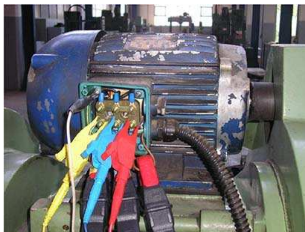
Σύνδεση αισθητήρων συσκευής διάγνωσης βλαβών στο ακροκιβώτιο ηλεκτροκινητήρα
