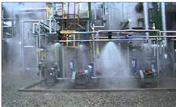
Σύστημα "Sprinkler" σε δοκιμή λειτουργίας του
